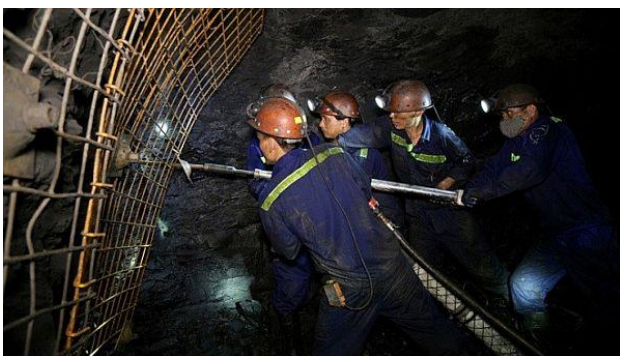
Hình 3. chống neo trong đào lò chuẩn bị [11]
