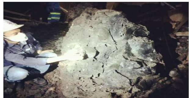
Hình 3c. Sập xỉ lò hơi tại nhà máy nhiệt điện Ung Bì ngày 23/03/2020
