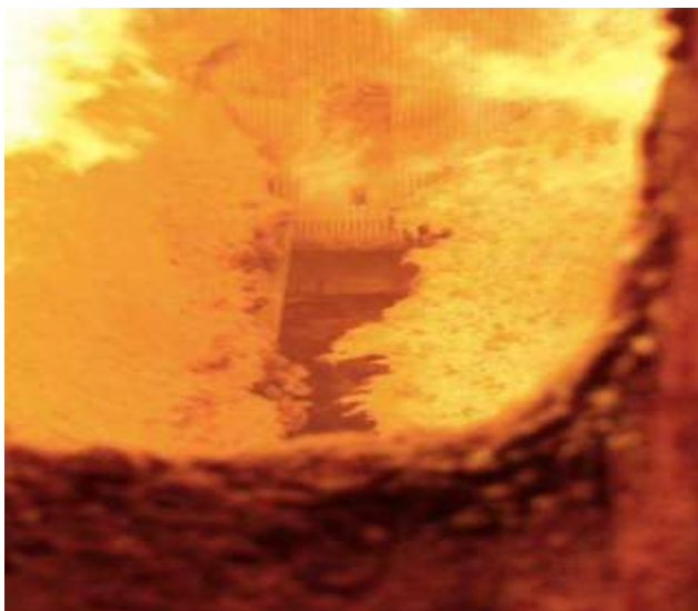
Hình 4. Đóng xỉ phễu lạnh lò hơi tại Công ty Nhiệt điện Nghi Sơn
